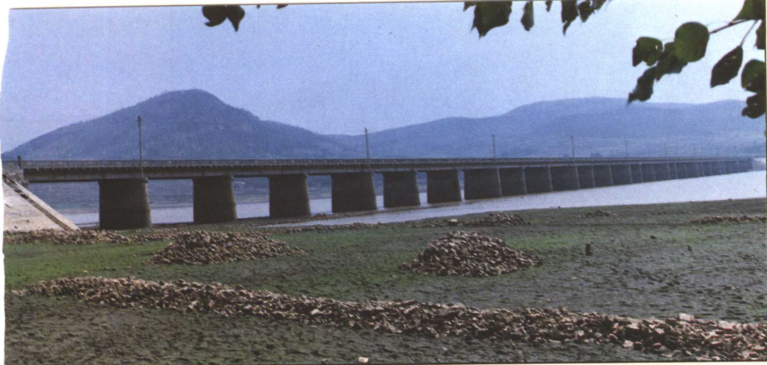
光明水库跨库桥
