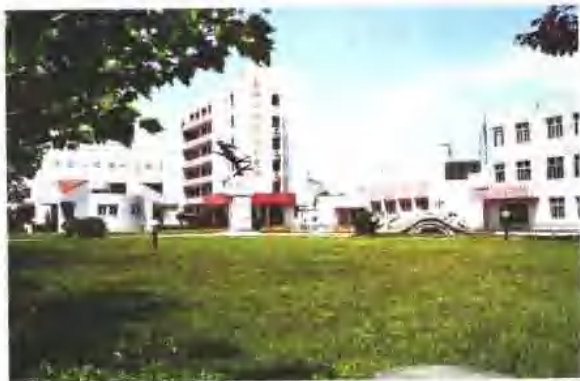
海洋工程技 术研究所大楼
