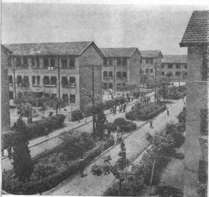
“新旧社会两重天”。这是解放后建造的光线充沛、空气流通、煤气卫生设备齐全的江南新村。
