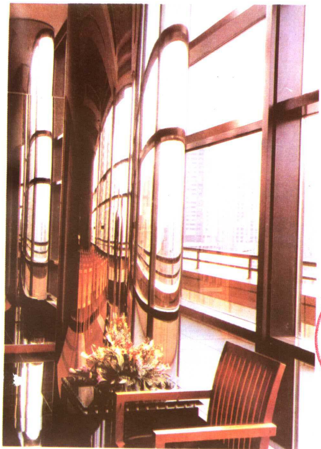
彩图 1 高层建筑中的不锈钢拉面
