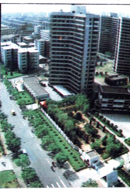
八角中里住宅小区 ▼
