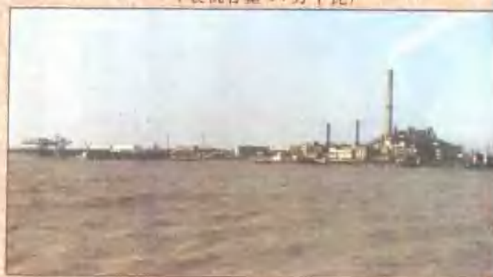
位于长江口的崇明电力公司发电厂 (装机容量 14 万千瓦)
