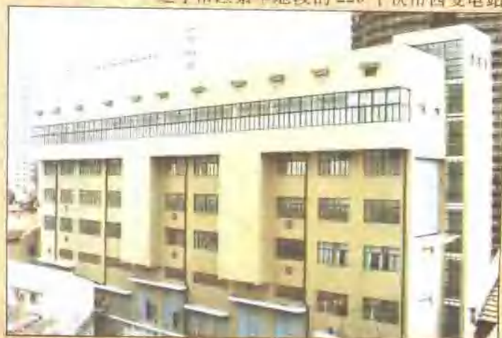
建于市区繁华地段的 220 千伏市西变电站
