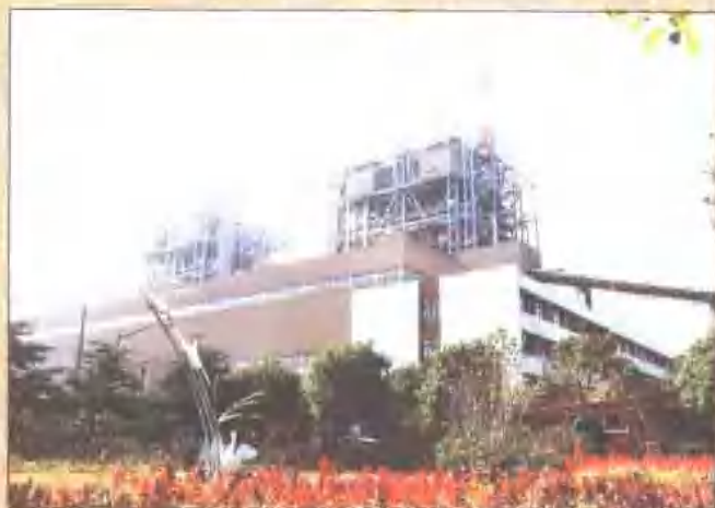
上海宝山钢铁总厂自备电厂 (装机容量 70 万千瓦)
