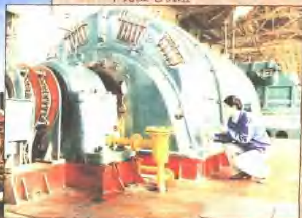
1960 年 9 月 25 日在闸北发电厂 投运的国产第一台双水内冷 5 万 千瓦发电机组
