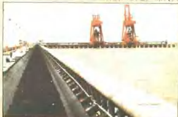
石洞口发电厂煤码头
