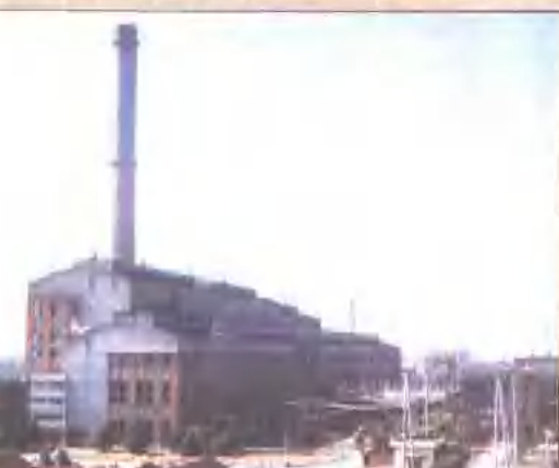
上海石油化工总厂热电厂 (装机容量 27.65 万千瓦)
