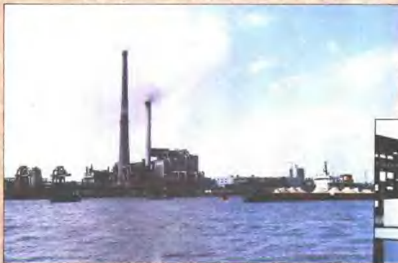
旧貌换新颜的杨树浦发电厂 (装机容量 26.15 万千瓦)
