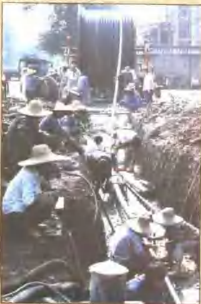
天宝变电站 220 千伏 充油电缆敷设施工
