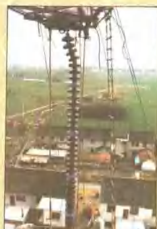
500 千伏葛洲坝—上海 直流输电线带电作业
