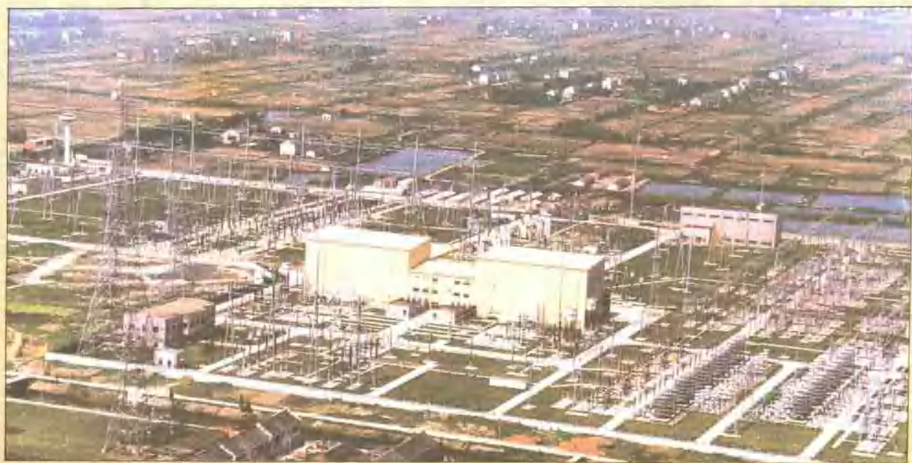
500 千伏南桥交直流变电站全景
