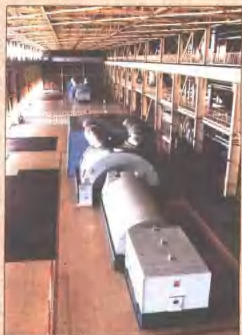
宝钢自备电厂 35 万千瓦汽轮发电机组
