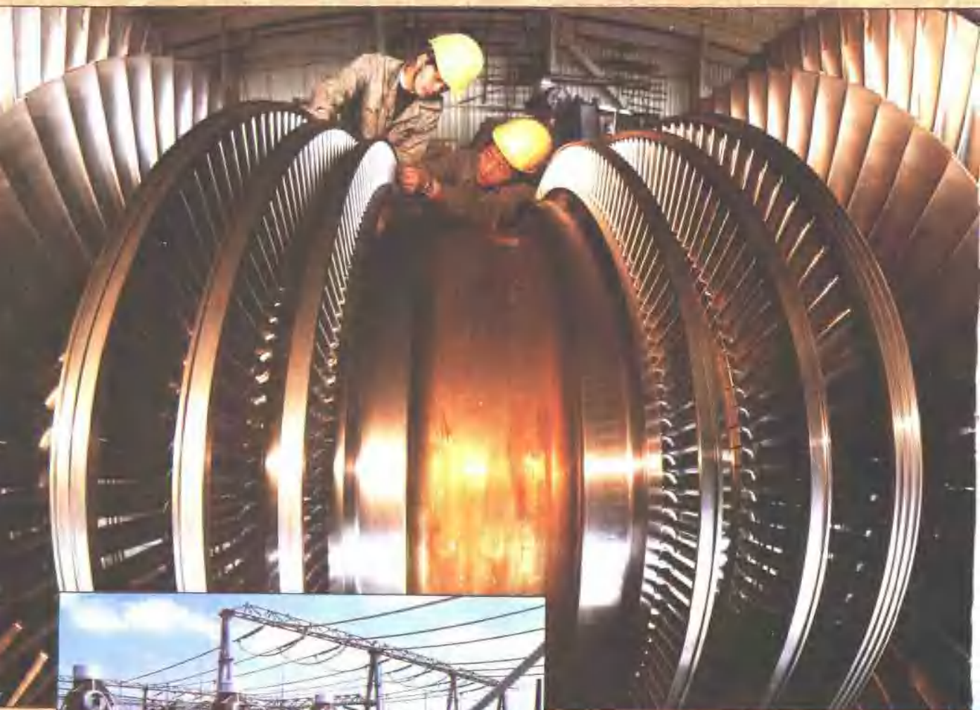
30 万千瓦的汽轮机转子正在紧张安装
