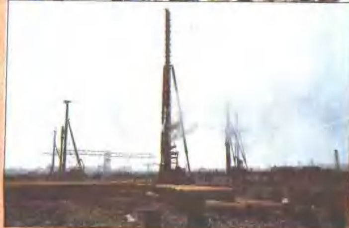
正在打桩的外高桥发电厂
