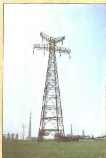
220 千伏吴淞过江铁塔
