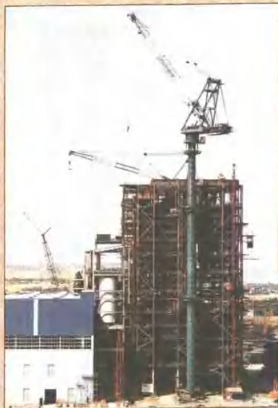
建设中的华能石洞口第二发电厂 (装机容量 120 万千瓦)
