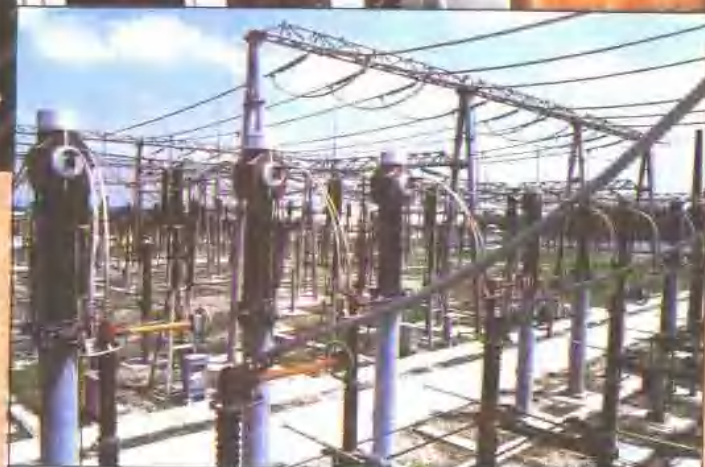
建设中的杨高变电站
