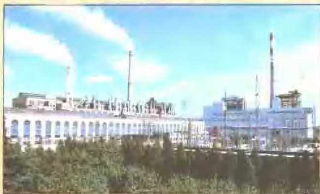
装机容量为35千瓦的 吴泾热电厂和扩建中 的六期工程厂房全貌
