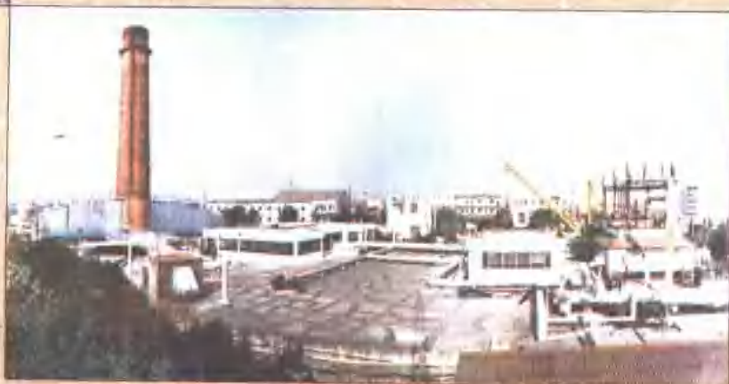
上海高桥石油化工公司热电厂半地下 厂房全貌 (装机容量 12.8 万千瓦)
