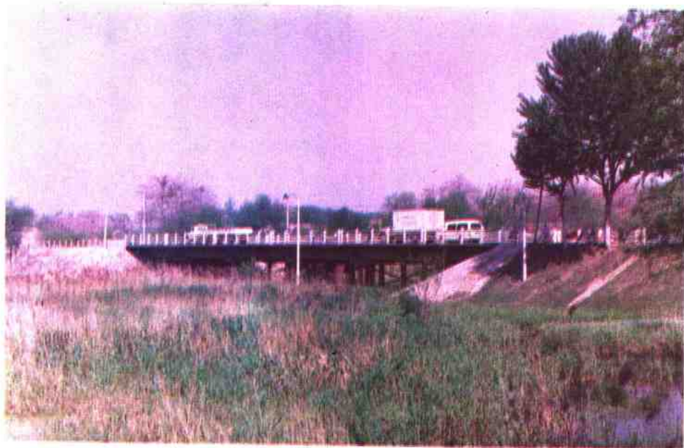
双河集排架桥
