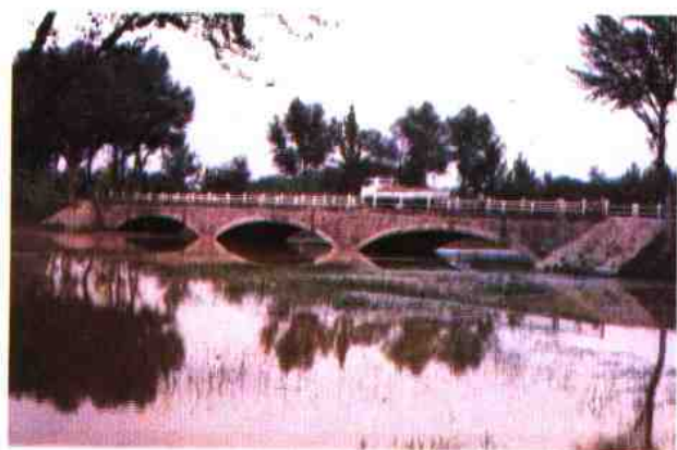
小留双曲拱桥
