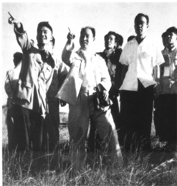
1959年9月，彭真在北京市密云水库工地视察。
