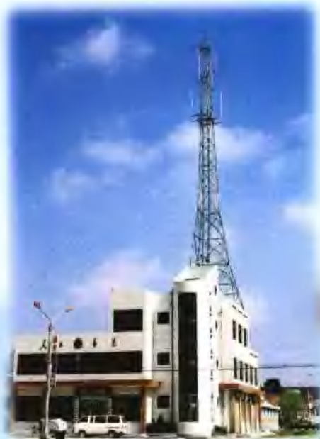
山前店邮电支局及耸立在楼顶上的移动通信铁塔
