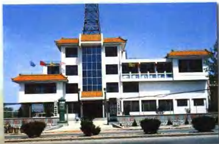
烟(台)青(岛)一级公路北侧冯格庄邮电支局
