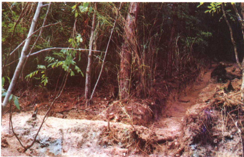
附图 14 施工中的马尾松林地小区
