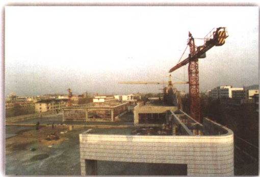
山东华鲁建安集团施工工地
