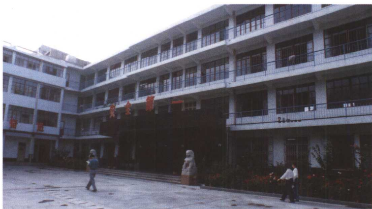
莒南电力总公司办公区一角
