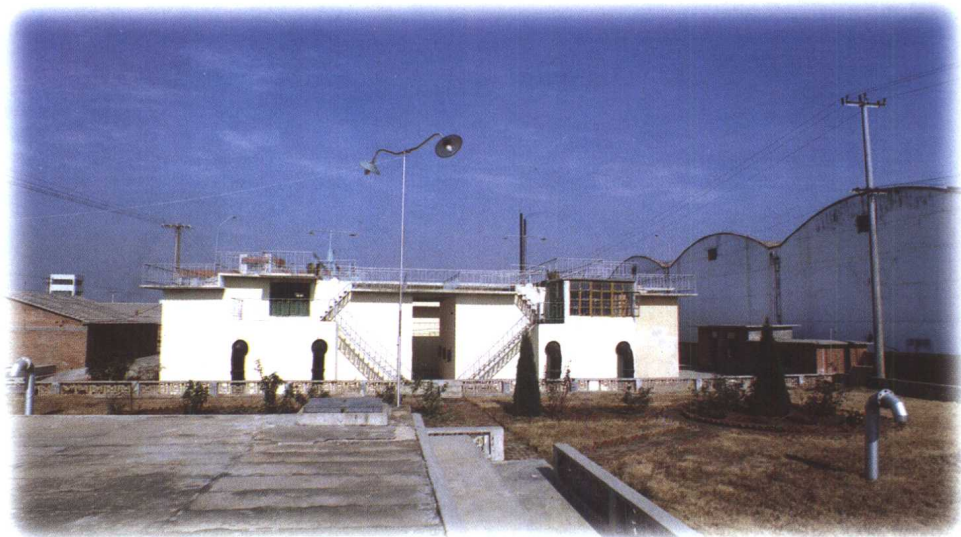
自来水公司供水净化厂虹吸滤池
