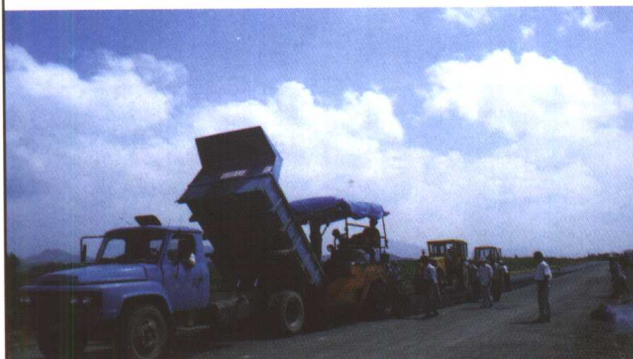
摊铺机在施工
