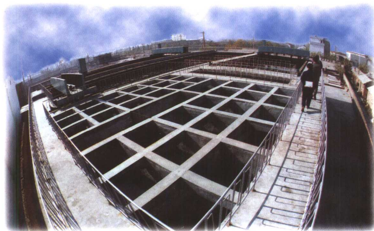
供水净化厂平流沉淀反应池
