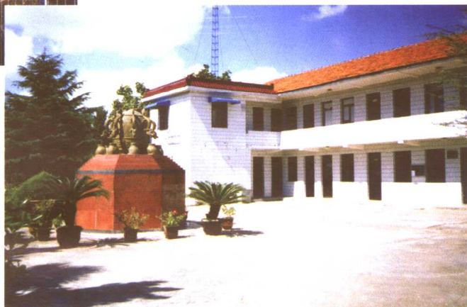
改造前后的海安地震台
