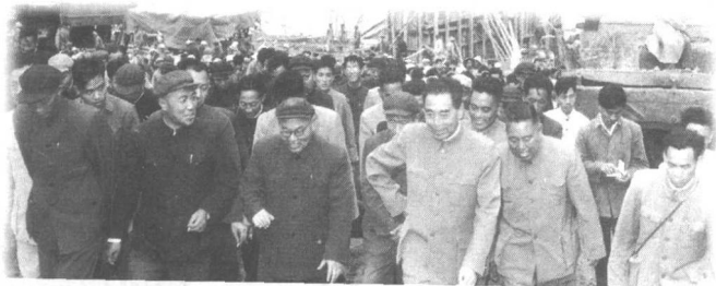
1959年10月，周恩来总理在黄河三门峡大坝工地视察。
