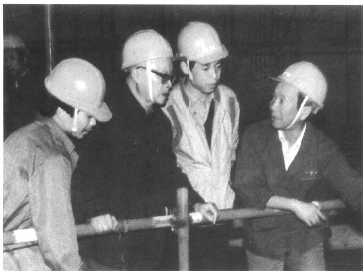
在秦山核电站了解设备安装情况(1989年10月)。
