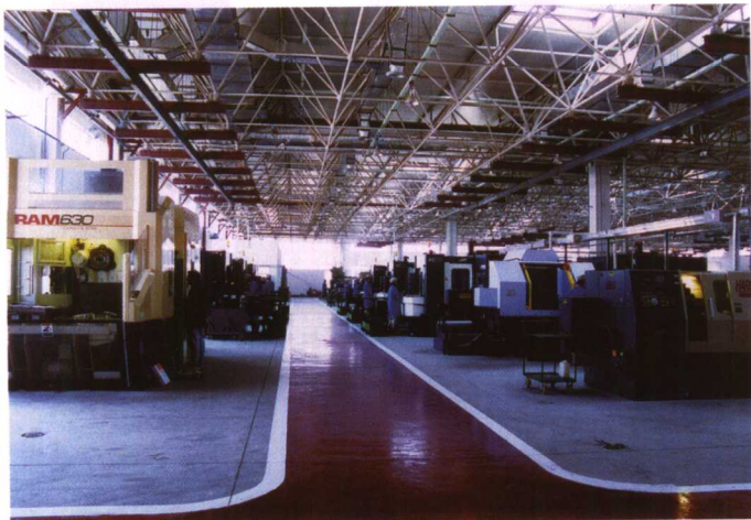
1997年北京华德液压工业集团有限责任公司建造的数控高压阀生产线
