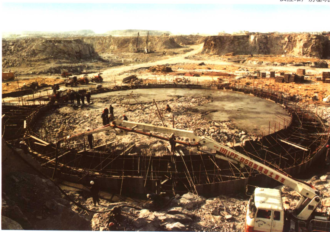
反应堆厂房基坑
