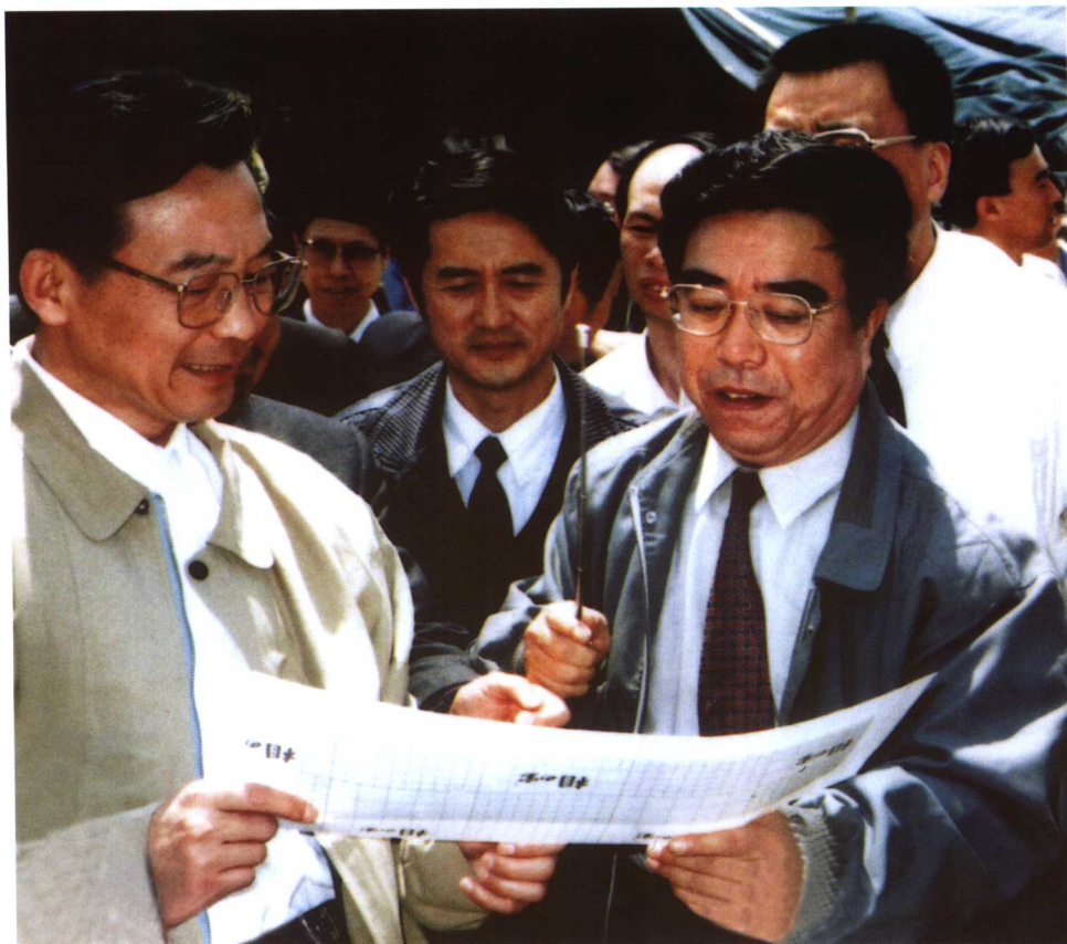
国务院总理温家宝在秦山第二核电厂施工现场视察
