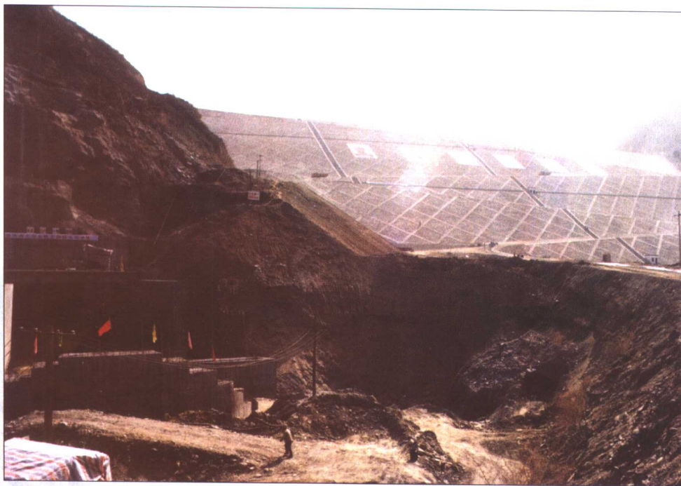
金盆水利枢纽工程水库大坝
