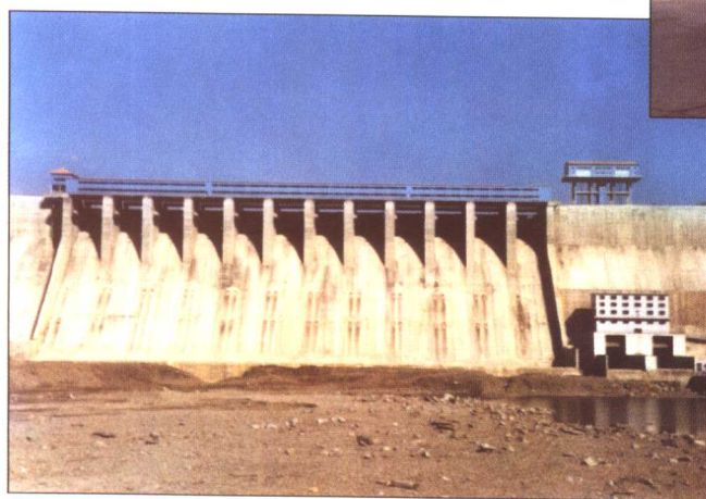
观音阁水库大坝泄洪坝段
