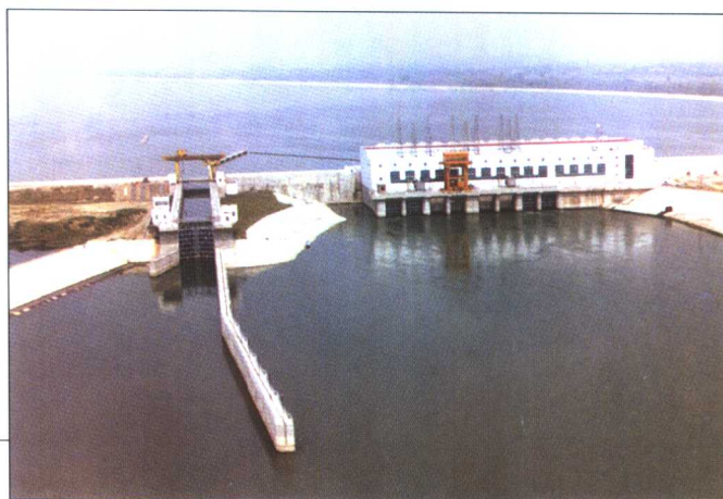
王甫洲水利枢纽的水电站 厂房和船闸
