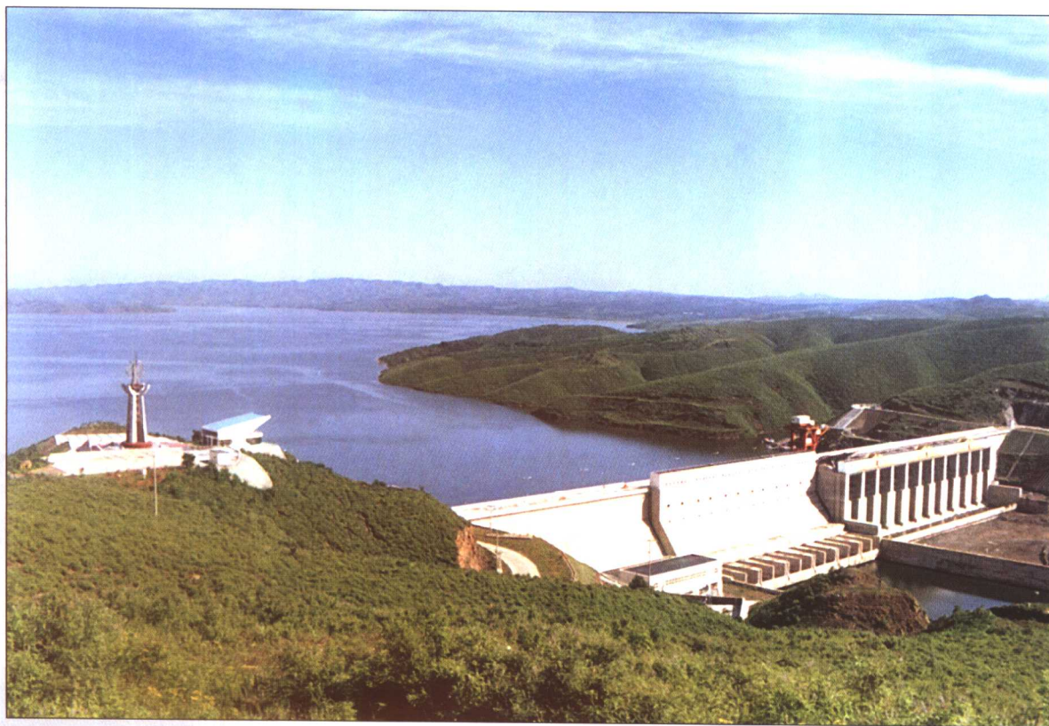
白石水库大坝库区全景
