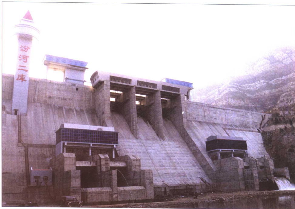
汾河二库枢纽水库大坝
