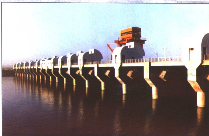
王甫洲水利枢纽水库泄水闸
