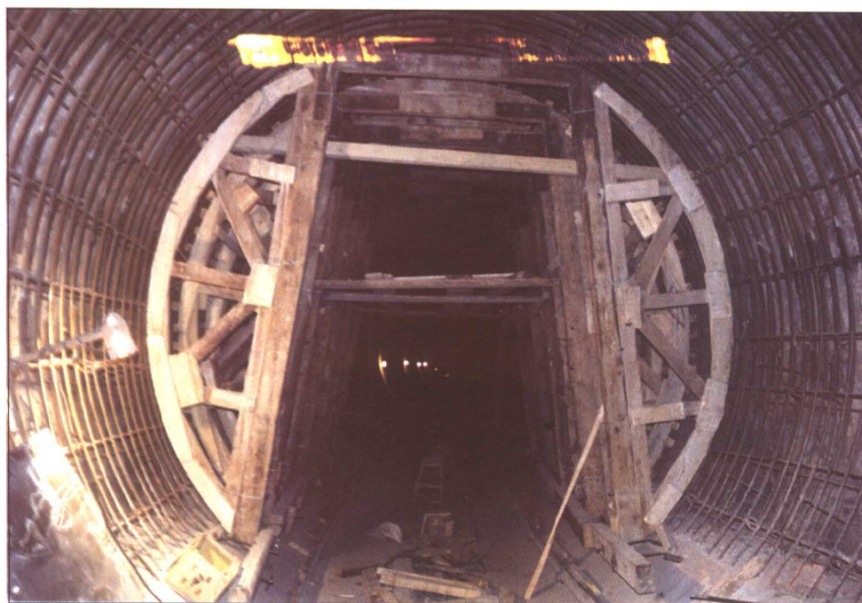
汾河二库枢纽水电站引水洞的施工支模
