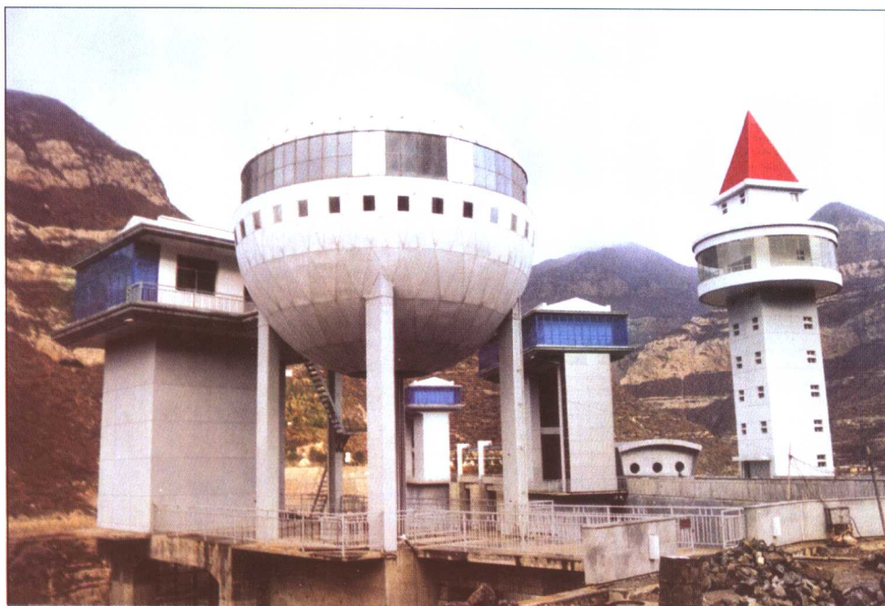
汾河二库枢纽水库的进水闸房、电梯井塔、启闭机房
