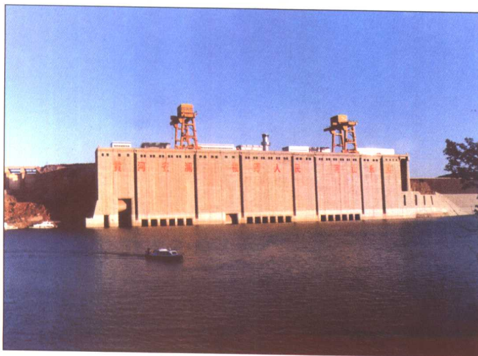
小浪底水利枢纽排沙泄洪工程 进水塔 (摄影: 刘凤翔)
