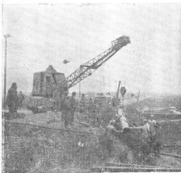
圖5 利用吊車埋設自來水管。
