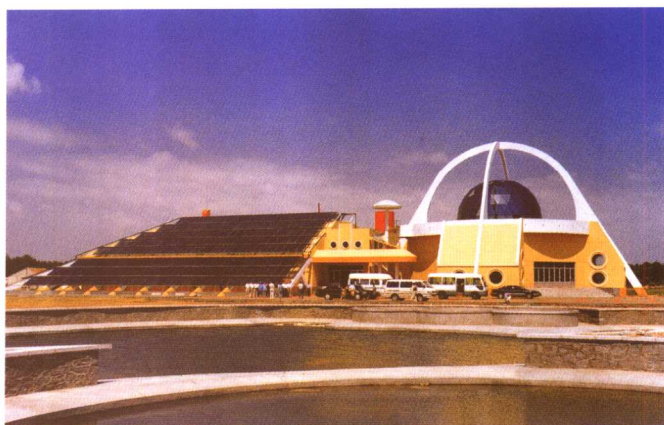
图10 太阳能空调系统（山东）
