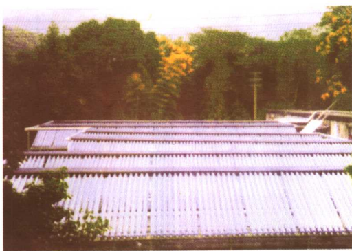
图3 热管真空管热水工程
