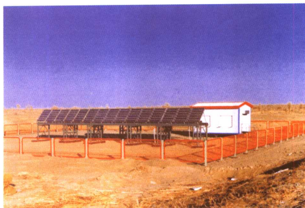
图 13 阴极保护系统用太阳能 光伏发电站 (新疆)
