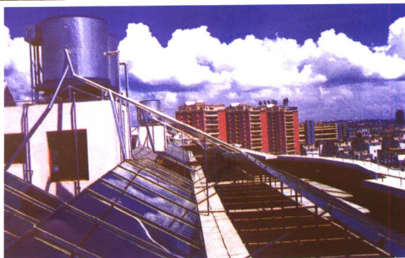
图4 平板太阳热水工程（云南）
