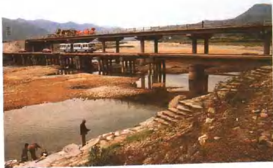
施工中的330国道船寮大桥
