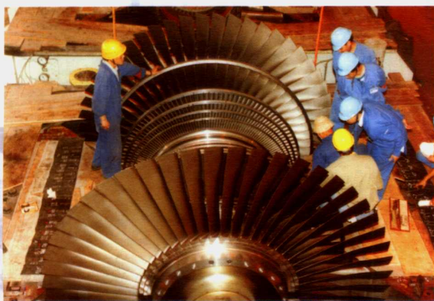
公司承担华能上海发电厂进口600MW机组大修现场
