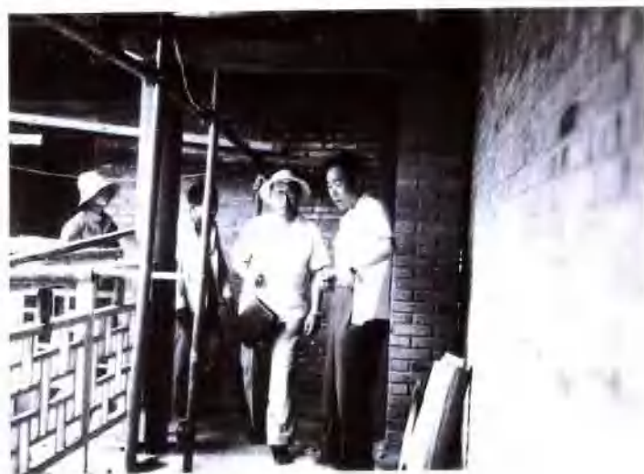
创业时期的田雄在建筑工地检查工作
