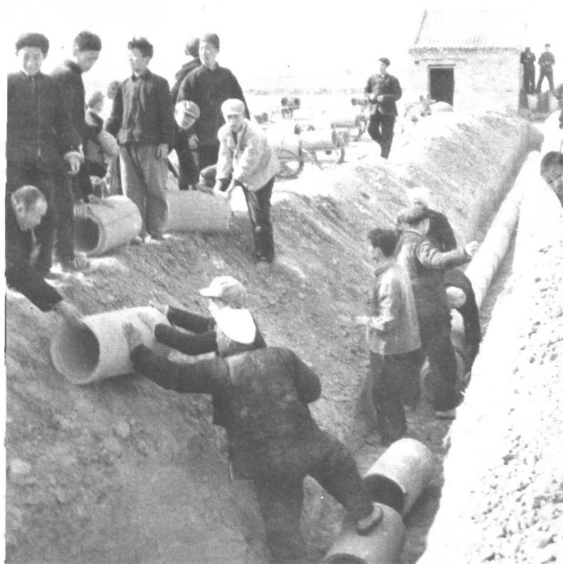
安装地下管道
