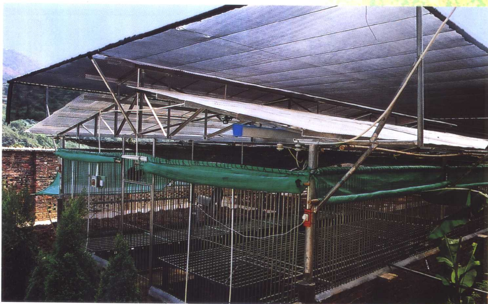
钢架结构兰室
