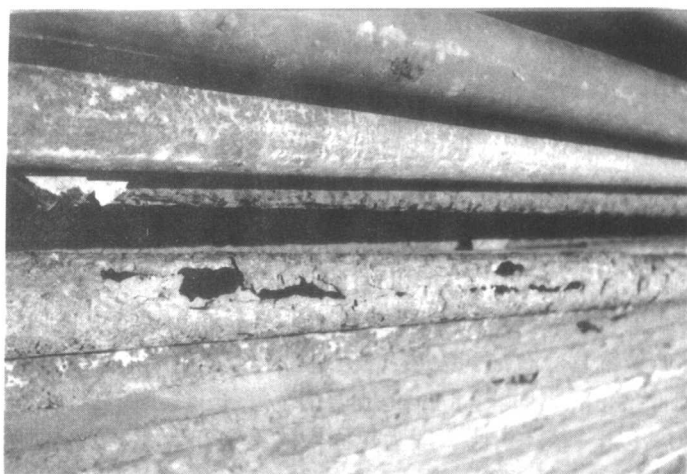
图 1—1 油管腐蚀穿孔形貌
