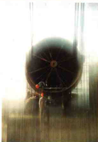
正在安装中的直径 \Delta \times 100 米大型回转窑(鲁南水泥厂)
