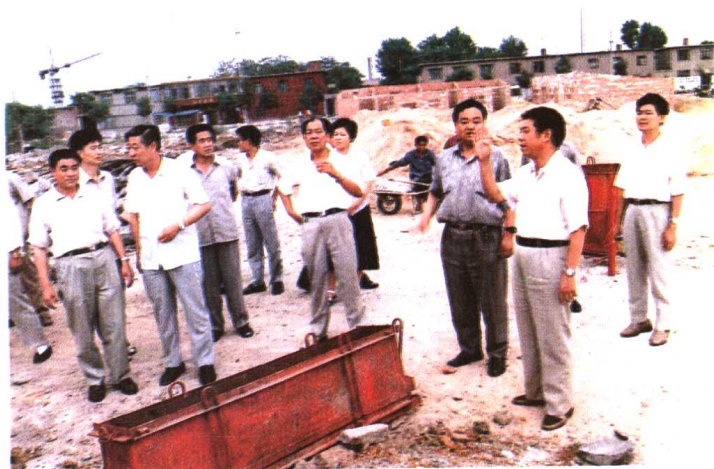
市中区委、区政府领导在新建的市第四十一中学工地上现场办公
