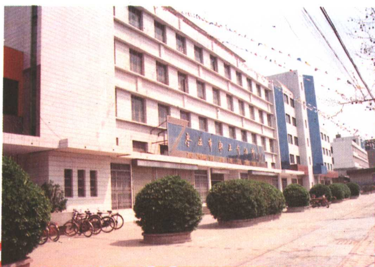
新改建的市劳动服务公司集办公、培训、职业介绍等于一体的大楼外貌
