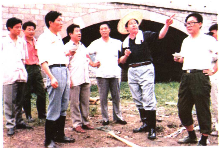
滕州市委、市政府领导在治理小黑河工地上现场办公
