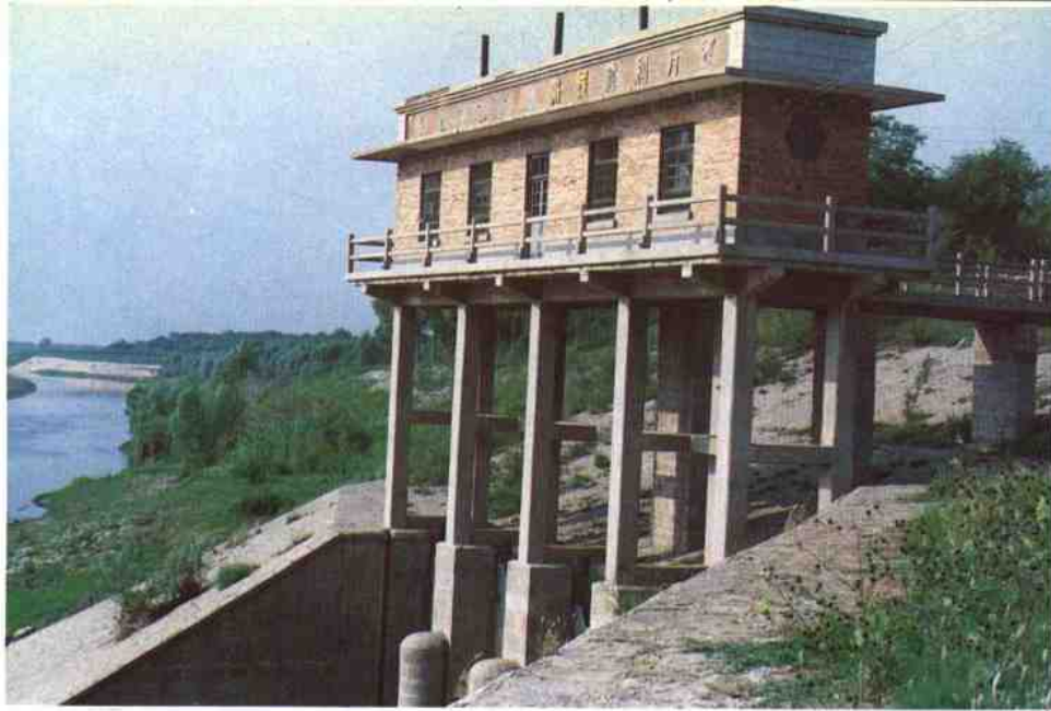
卫运河土龙头引水闸
