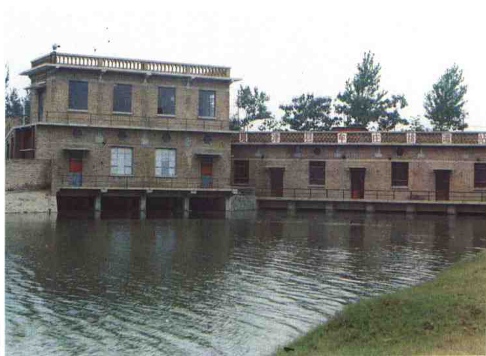
马颊河牟庄排灌站
