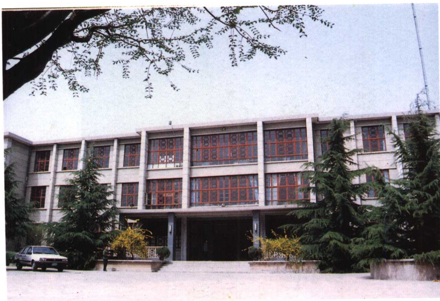
中共沂南县委办公楼
