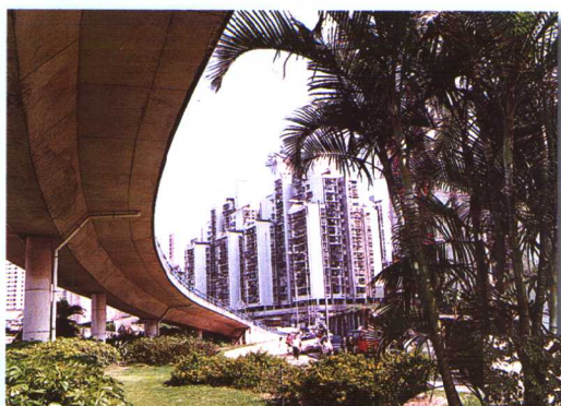
玲珑的都市，一座座高架桥凌空而起。
