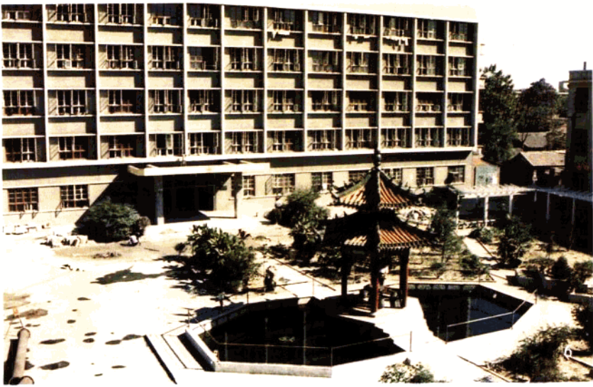
6. 济宁市市中区人民医院 病房楼。
