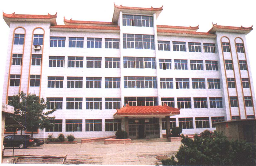
费县财政局办公楼全景
