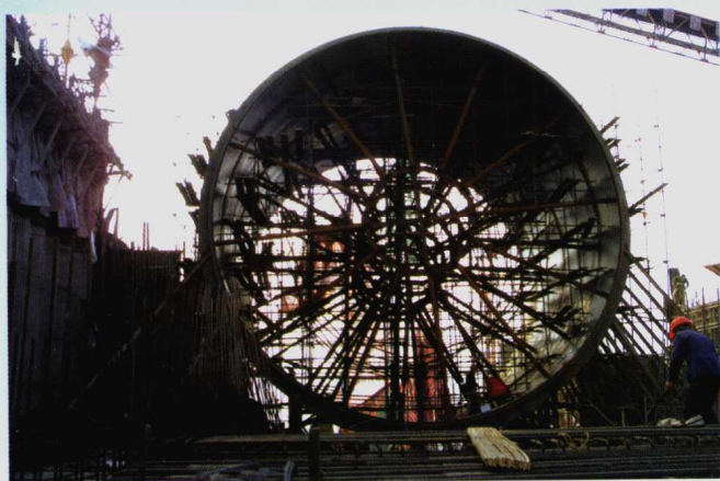
三峡枢纽工程左岸电站引水压力钢管现场施工
