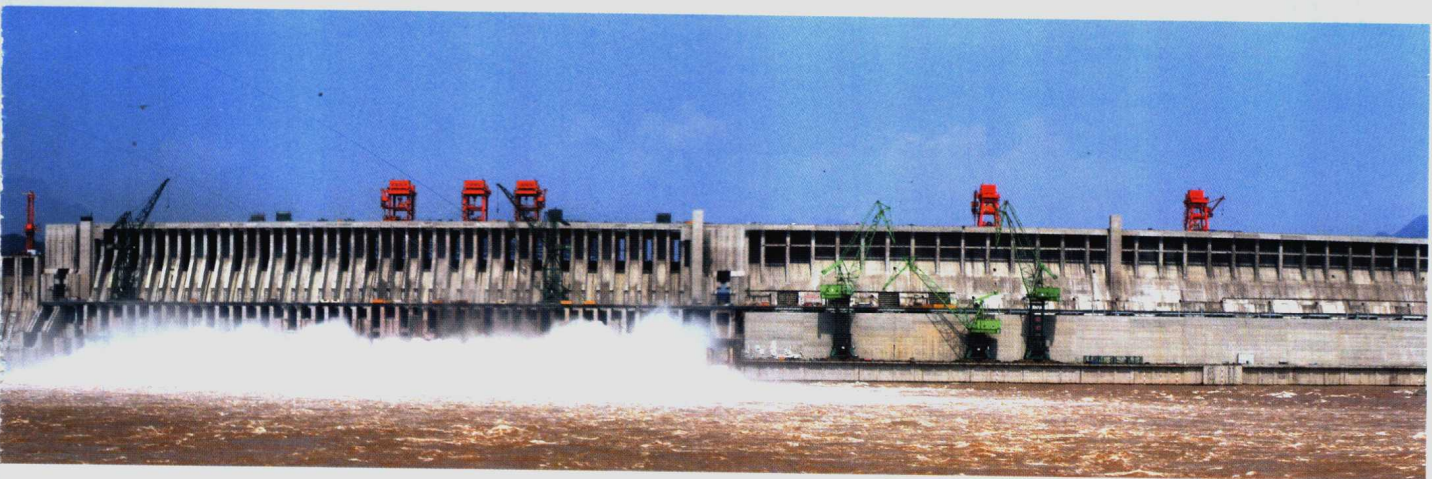
三峡二期枢纽工程泄洪坝及左岸电站下游全貌
