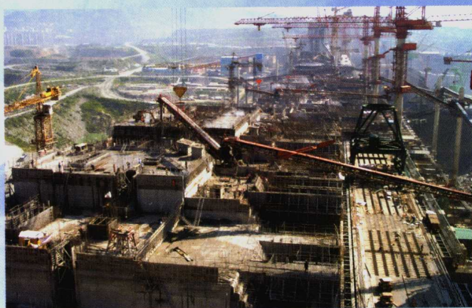
三峡枢纽工程泄洪坝段混凝土施工现场
