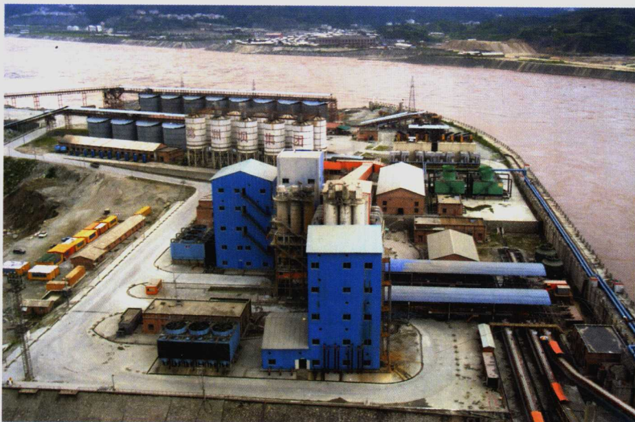
三峡二期工程左岸高程90m混凝土生产系统
