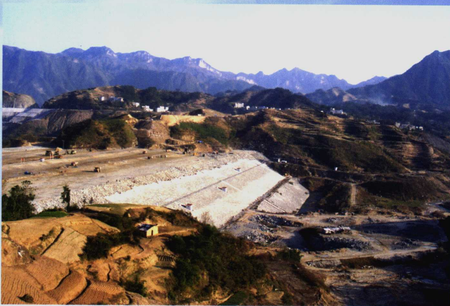
三峡茅坪溪防护土石坝填筑施工
