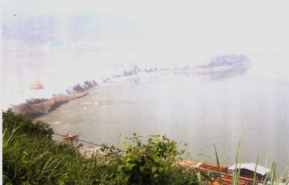
2003年7月1日三峡枢纽工程二期下游土石围堰爆破拆除
