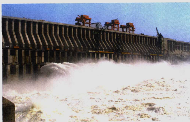
2003年汛期三峡枢纽工程大坝泄洪深孔泄流
