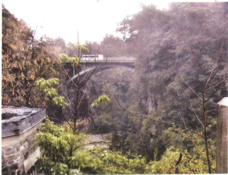
伤心桥的高桥，凭虚凌空，下临无地。【伤心桥】
