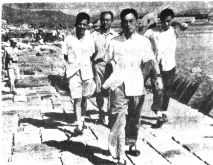
福建省政府副主席叶飞同志在厦门海堤工程指挥部主任张维兹同志陪同下，巡视施工中的海堤工程。
