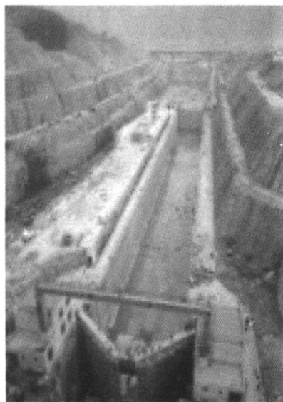
图 0-2 施工中的长江三峡五级船闸
