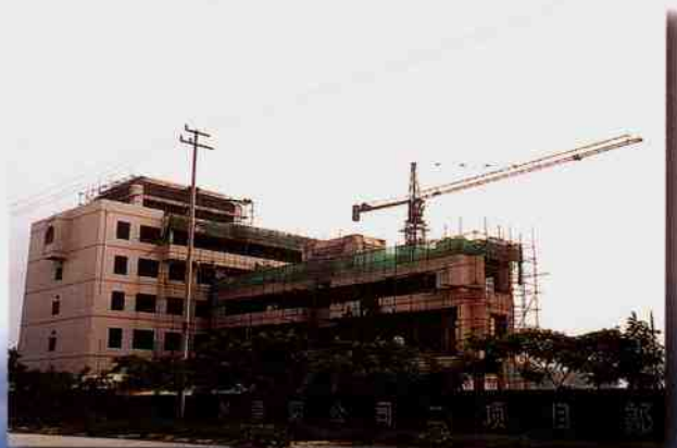
建设中的开发区分院
