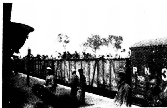
移民在道口上火車後將開時情形
