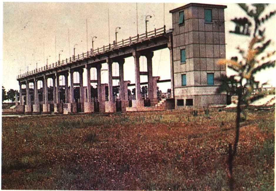
马颊河孙马村拦河蓄水挡湖闸
