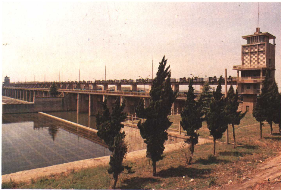
南四湖出口工程——韩庄节制闸
