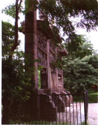
西石牌坊侧面
