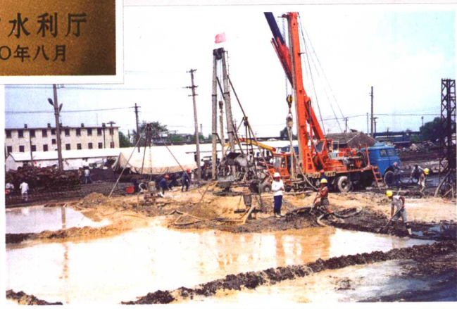
莱山后青钢高炉基础处理
