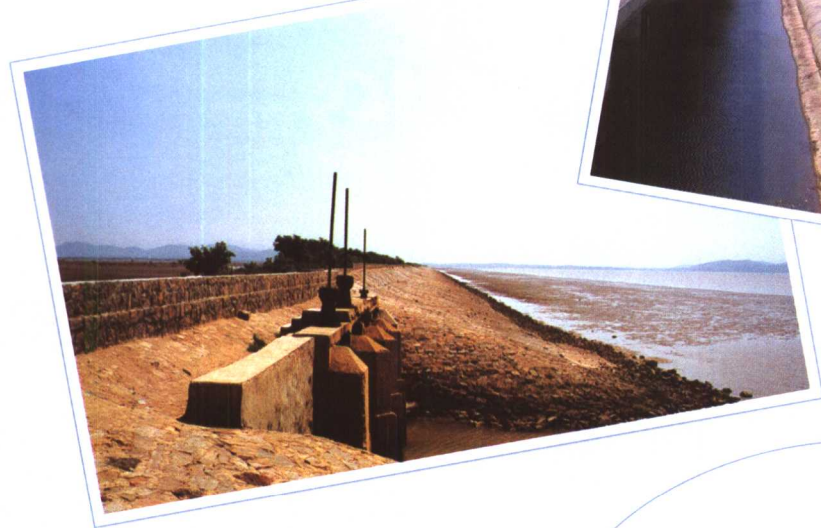
大桥盐场防潮坝
