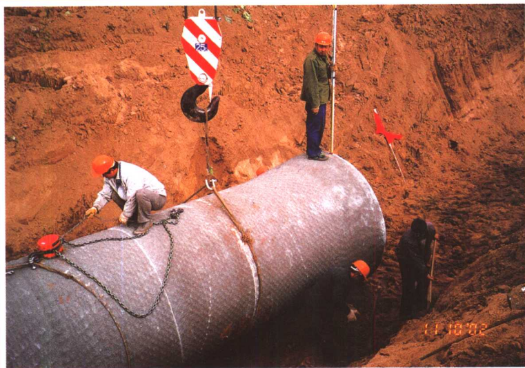
大沽河水源地供水设施改造工程工作人员按装管道
