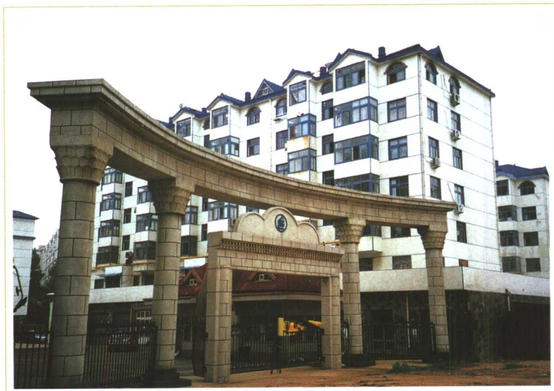
由水利建安公司承建的5000平方米青岛海牛花园10号楼、门房
