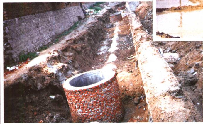
1999年即墨城区污水管道工程建设
