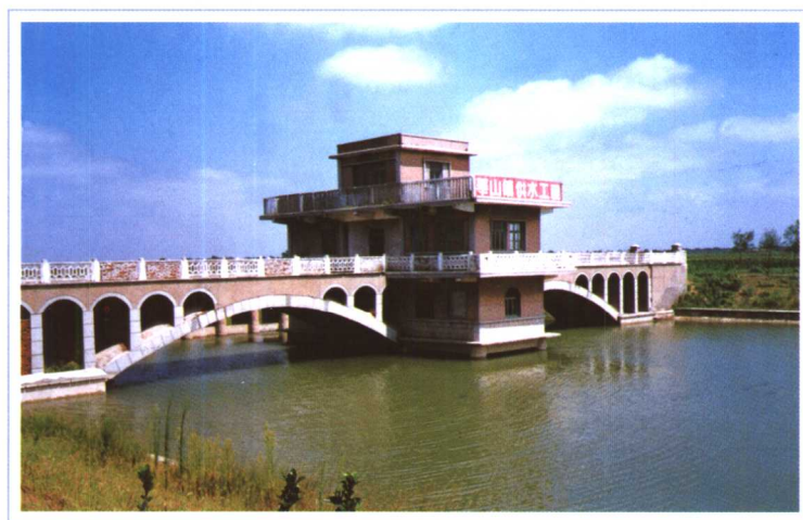
龙化河水上扬水站
