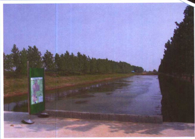
袁家庄灌区配套改造工程的主干渠
