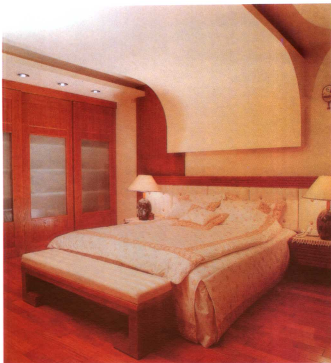
弧型天花以间接照明的方式，改善压梁的缺点，简洁朗爽。
