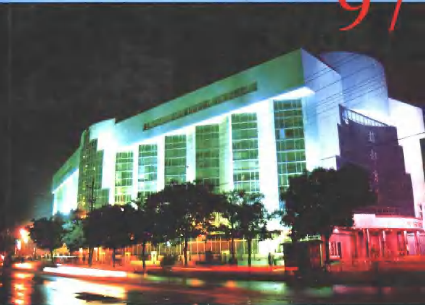
邯郸赵都商场集团总公司营业大楼
