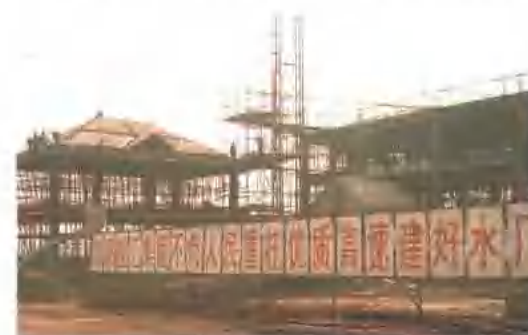
铁西水厂施工现场
