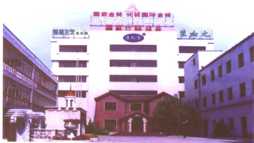
天津中山路达仁堂制药厂厂房全景
