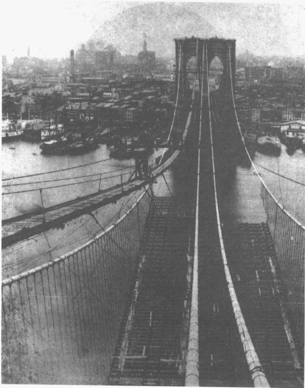
图 1.4 建造中的布鲁克林大桥（出自纽约市美术馆）
