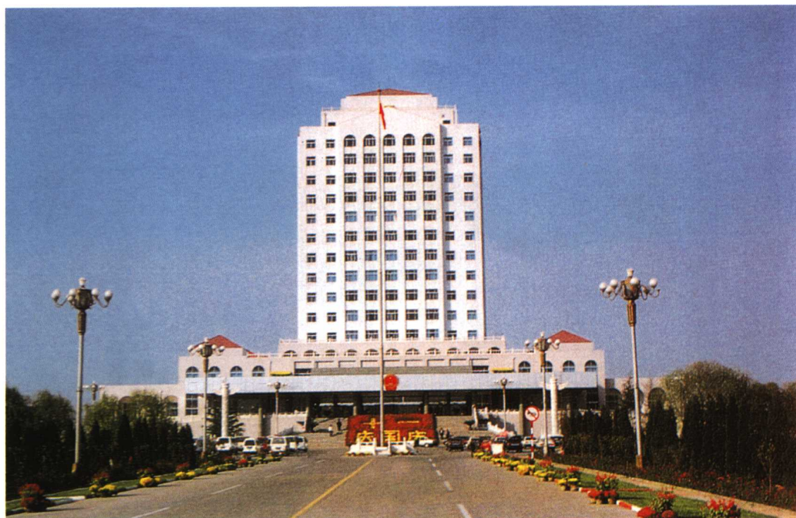
罗庄区行政办公大楼
