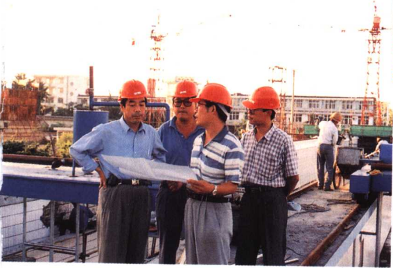
市自来水公司领导在给水处理工程工地研究施工方案
