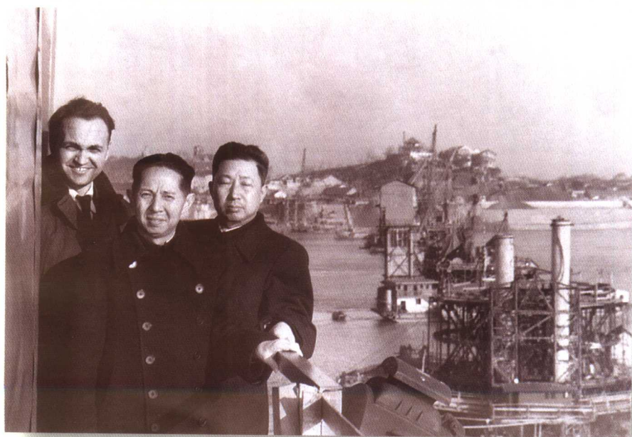
1956年在武汉长江大桥建筑工地左起苏联专家西林、郭洪涛、王首道
