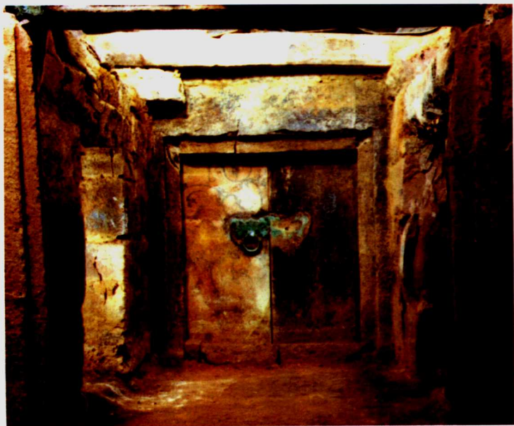
墓室第二道门 右边的铜铺首已被断落的石块打落。
