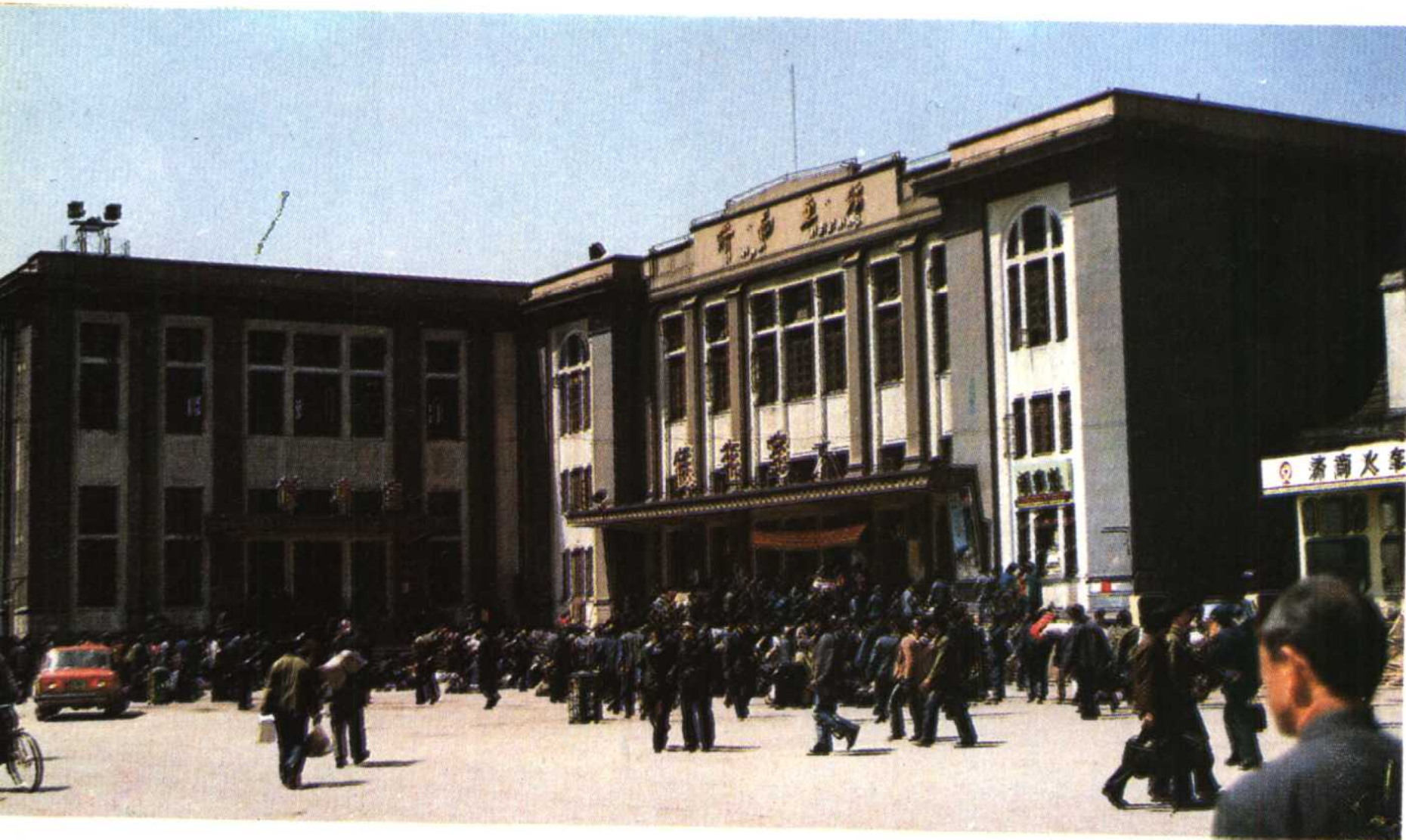
1958年建成的 济南车站候车室
