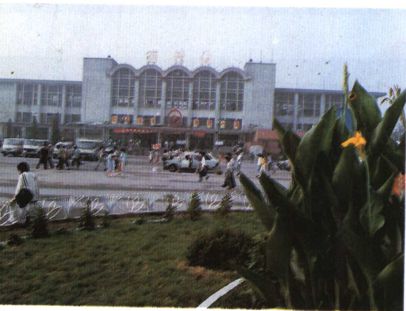
1975年建成的张店车站候车大楼
