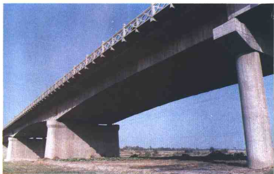
京深线洛河大桥
